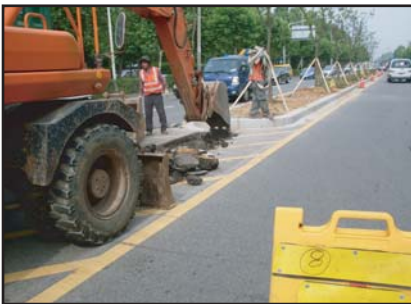
④ Dig up the road
